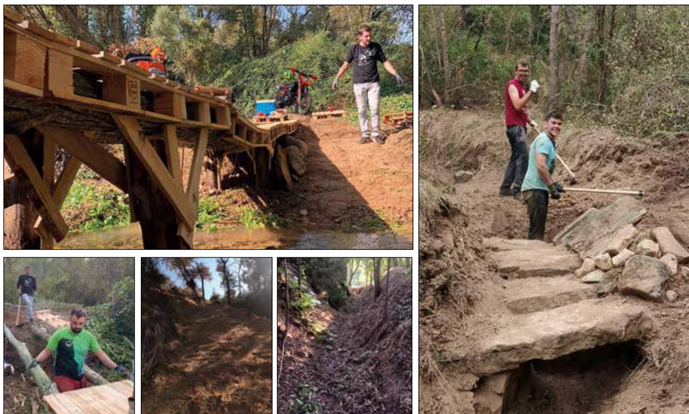
El pont sobre el Boix (dalt esq), un dels ponts originals (dreta), una rampa (baix esq) i diferents indrets del corriol | CUDOS
